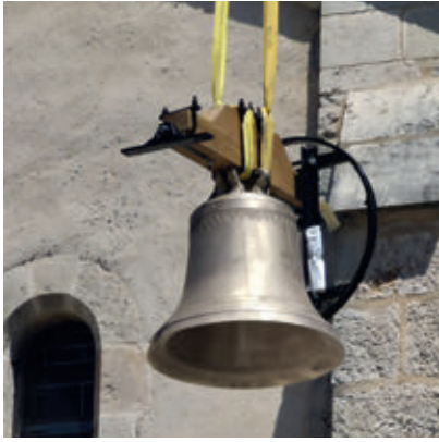
Enfin, la cloche moyenne qui, à son tour, rejoint la tour.
